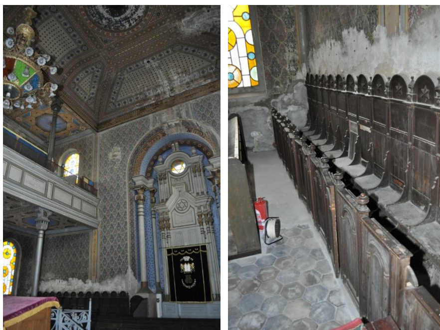
A felújításra váró zsinagóga.
